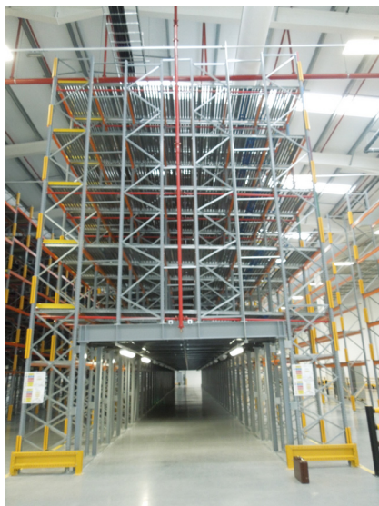
Instalação dinâmica de paletes com túnel de picking
